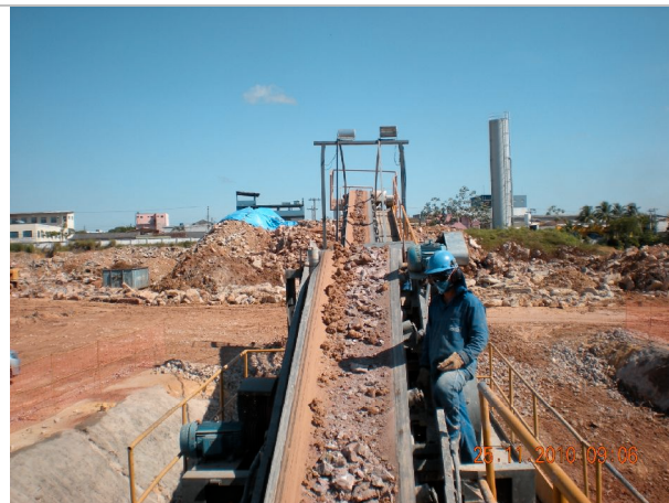
Britagem do resíduo de demolição
