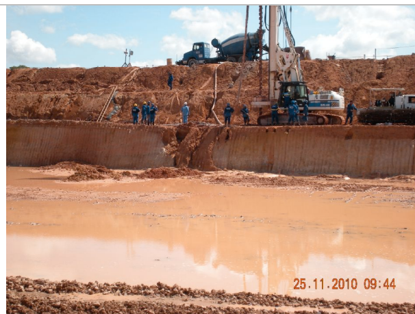
Perfuração no primeiro nível arquibancada
