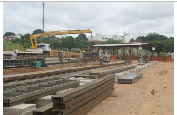
Pré-fabricação de Vigas de Concreto Armado
