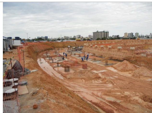
Lado leste – bloco de fundações e estacas
