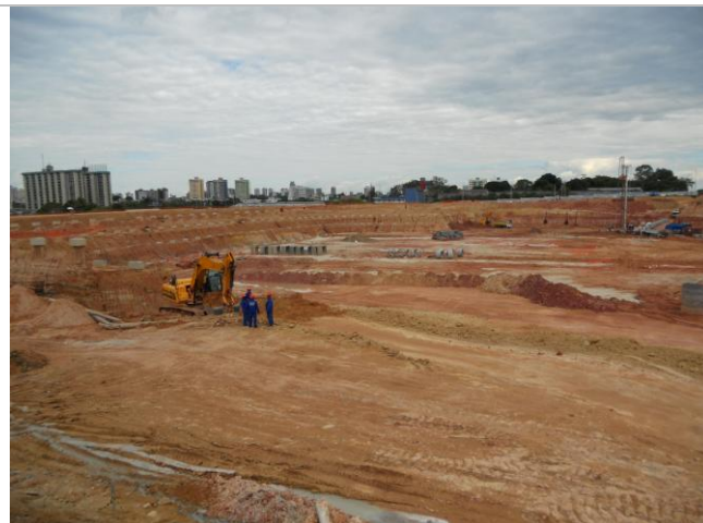
Vista lado leste/centro
