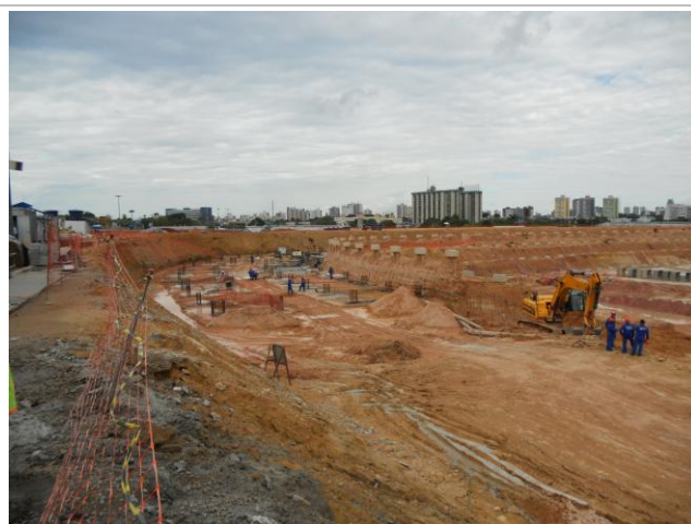
Lado leste – bloco de fundações e estacas
