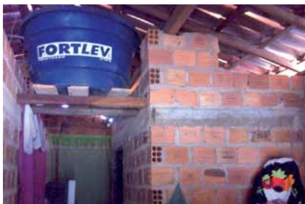
Figura 1 – Aspecto do interior de unidade habitacional entregue no em Fortuna/MA
