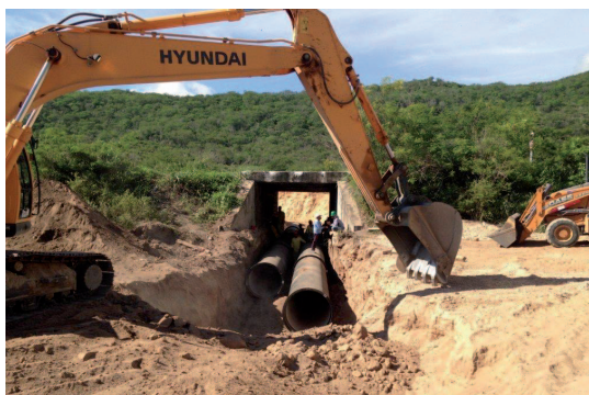
Figura 1 - Adutora do Agreste
