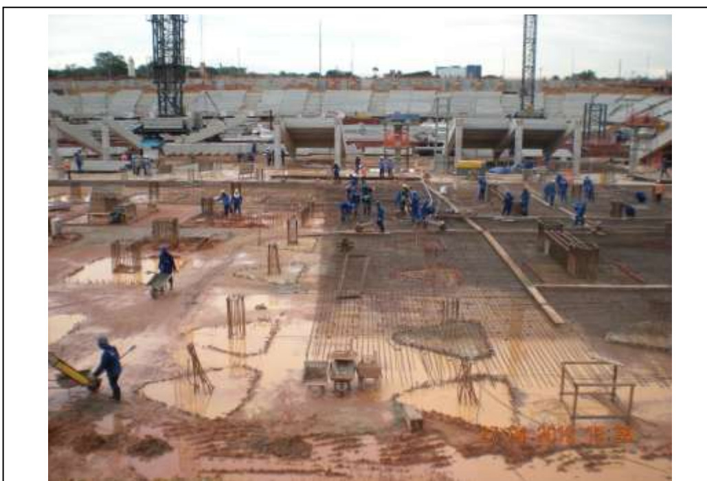
FOTO 2 – BLOCOS E CINTAS E ARMAÇÃO DA LAJE DE PISO DA ADMINISTRAÇÃO
