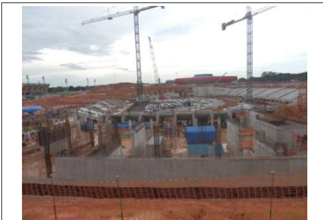
FOTO 1 – VISTA GERAL DA OBRA – LADO LESTE MAIS AVANÇADO
