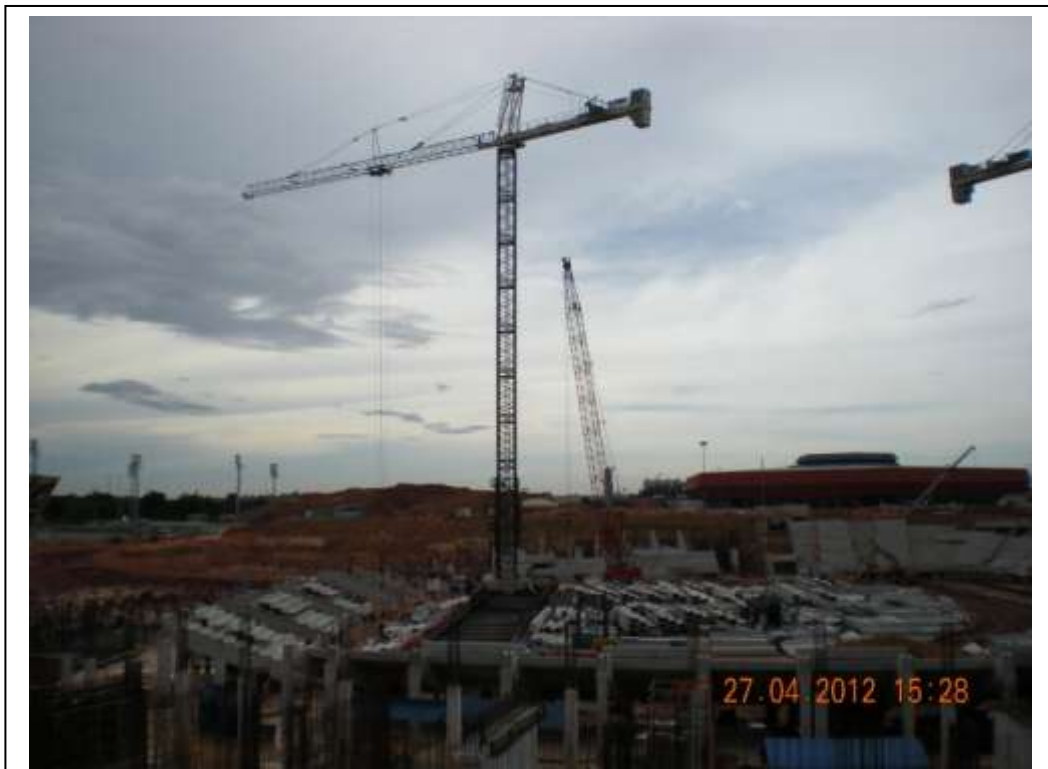
FOTO 5 – GRUAS E GUINDASTE EM OPERAÇÃO
