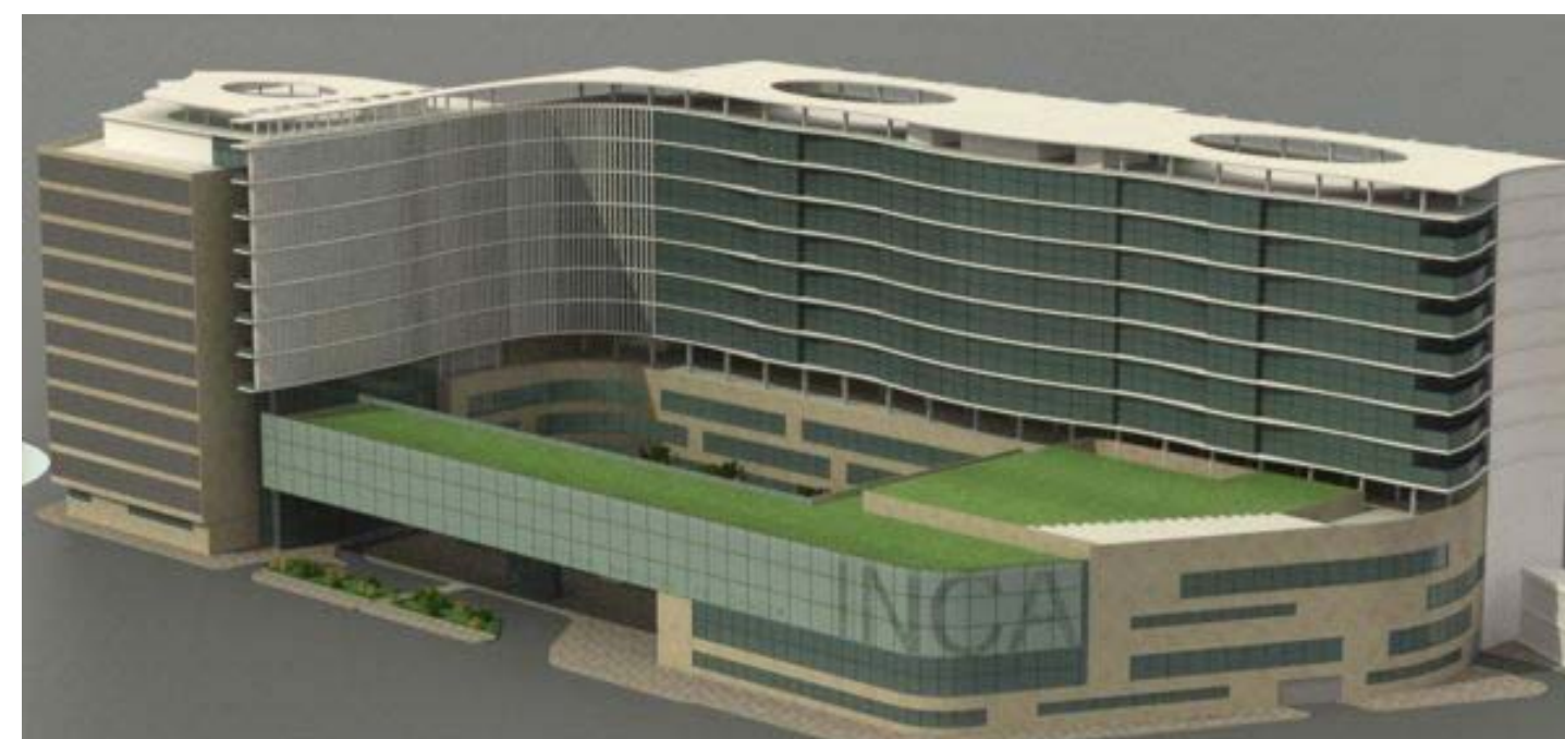
Figura 49. Construção do Campus Integrado do Instituto Nacional do Câncer
