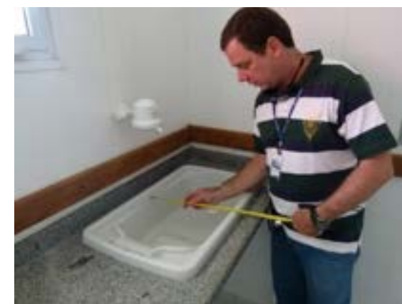
Figura 24. Defeitos constatados na obra em Anápolis (GO)
