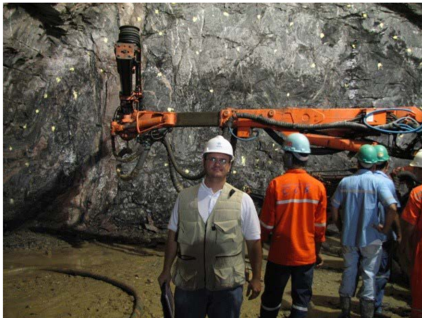
Figura 16. Perfuração precisa com o uso de “jumbo” para colocação dos explosivos no túnel
