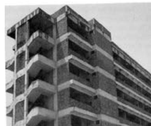
Obra: Hospital Geral de Maceió (AL)
