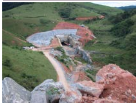
Figura 18. Região de escavação do túnel 3: desmatamento a seco
