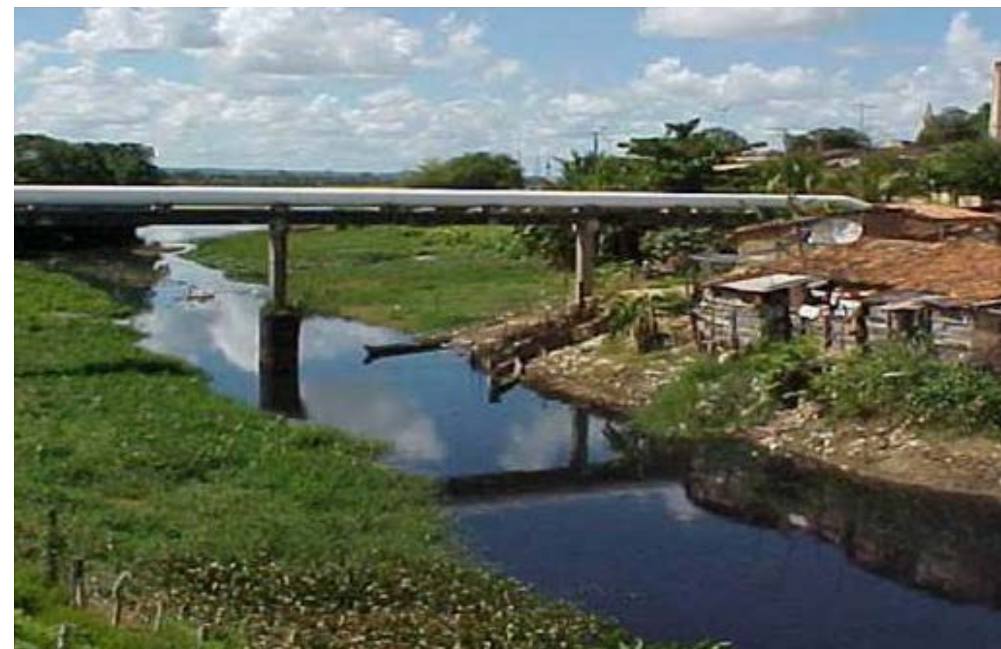
Figura 14. Obra: duplicação da adutora do São Francisco em Sergipe
