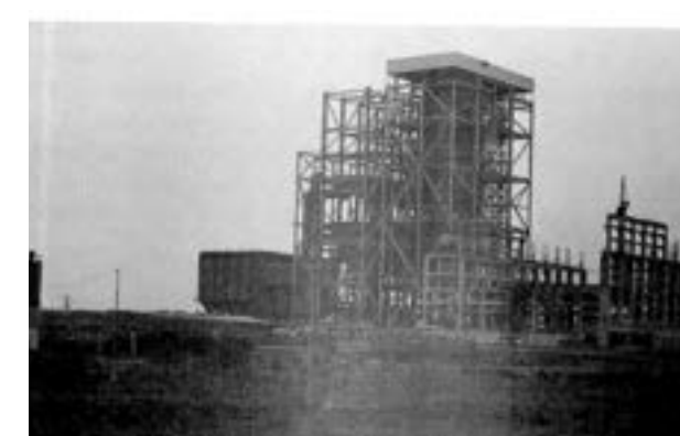
Obra: Usina termelétrica de Jacuí (RS)
