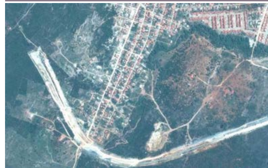
Figura 58. Imagem de satélite da Ferrovia de Integração Oeste-Leste (Fiol)
