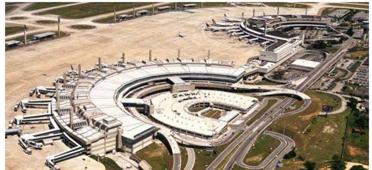
Figura 51. Reforma e adequação do terminal de passageiros 1 do Aeroporto Internacional do Galeão (RJ)
