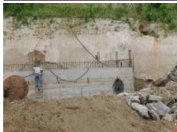
Figura 19. Contenção de talude na região da casa de força de Simplício
