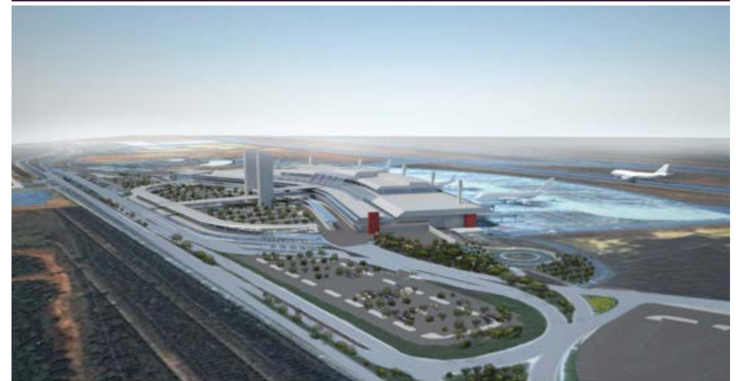
Figura 45. Reforma, adequação e ampliação do terminal de passageiros do Aeroporto Internacional de Confins/Tancredo Neves (MG)
