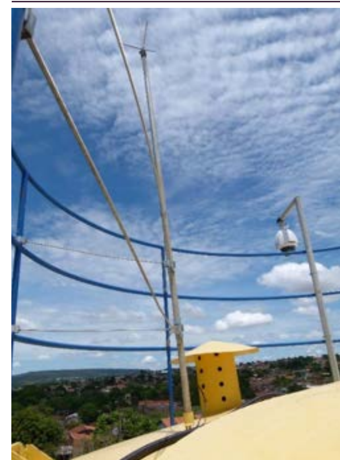
Figura 29. Alto da caixa d'água em obra em Anápolis (GO)
