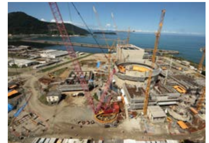
Figura 33. Angra 3, visão geral da usina
