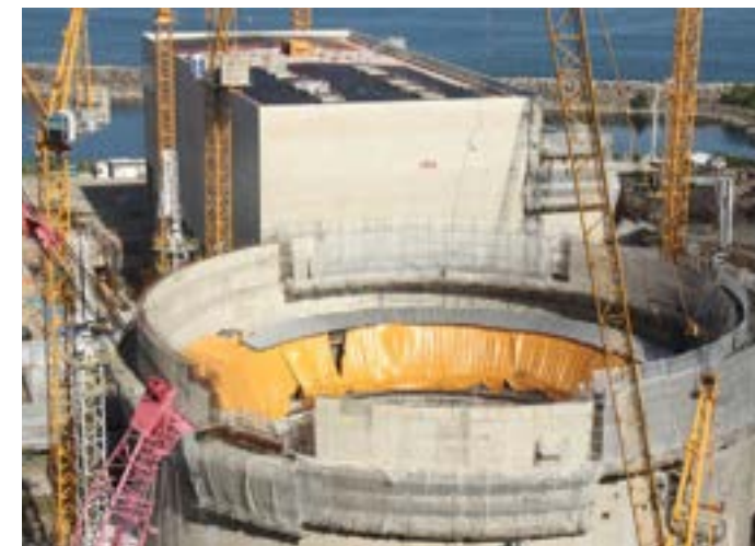
Figura 32. Angra 3, edifício do reator
