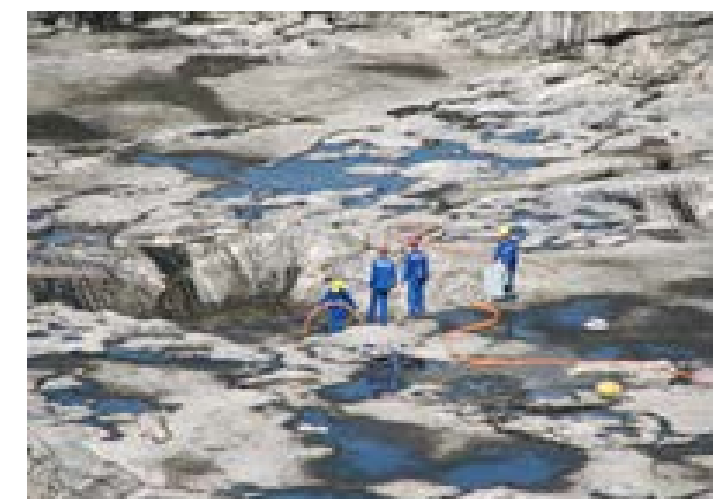
Figura 35. Angra 3, esgotamento da cava
