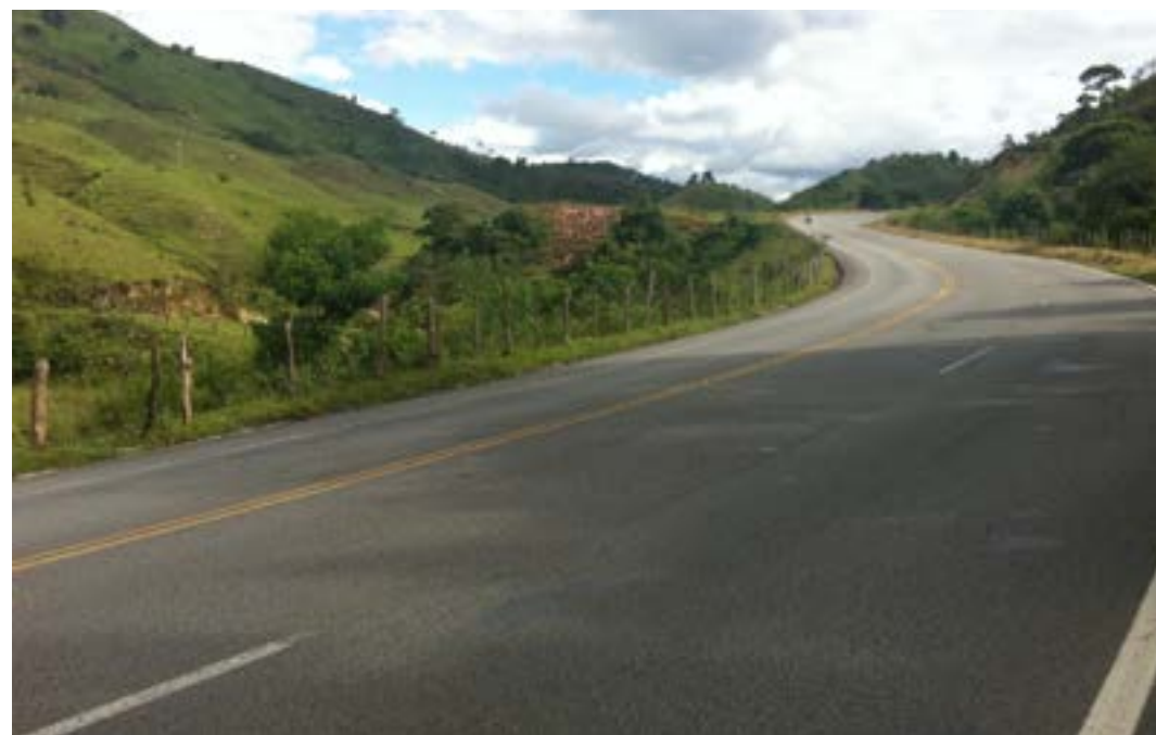
Figura 55. Obras de duplicação da BR-381 (MG) – Lote 3.1
