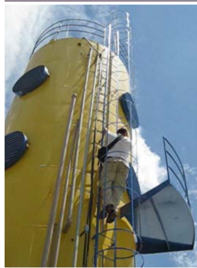
Figura 28. Subida até a caixa d'água em obra em Anápolis (GO)
