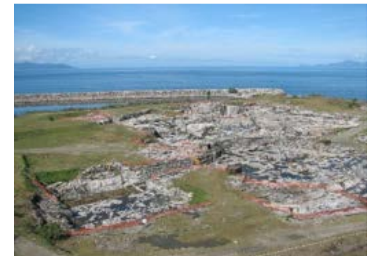
Figura 31. Angra 3, panorâmica da fundação
