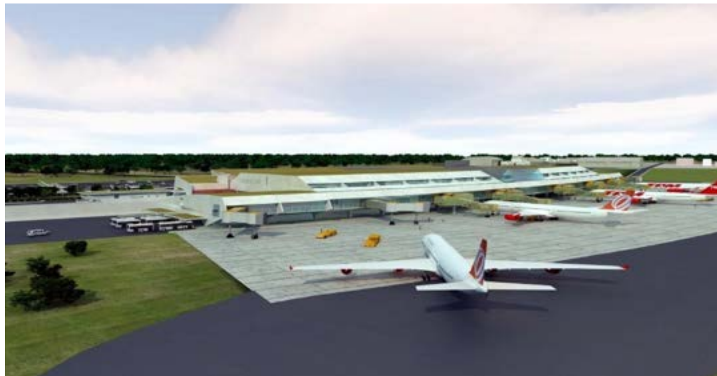
Figura 46. Reforma e ampliação do TPS-1 do Aeroporto de Manaus (AM)
