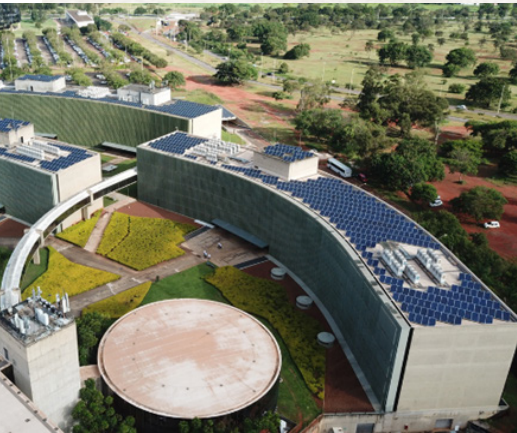
Fotografia 2 - Usina fotovoltaica dos Anexos I, II e III do complexo arquitetônico em Brasília-DF
