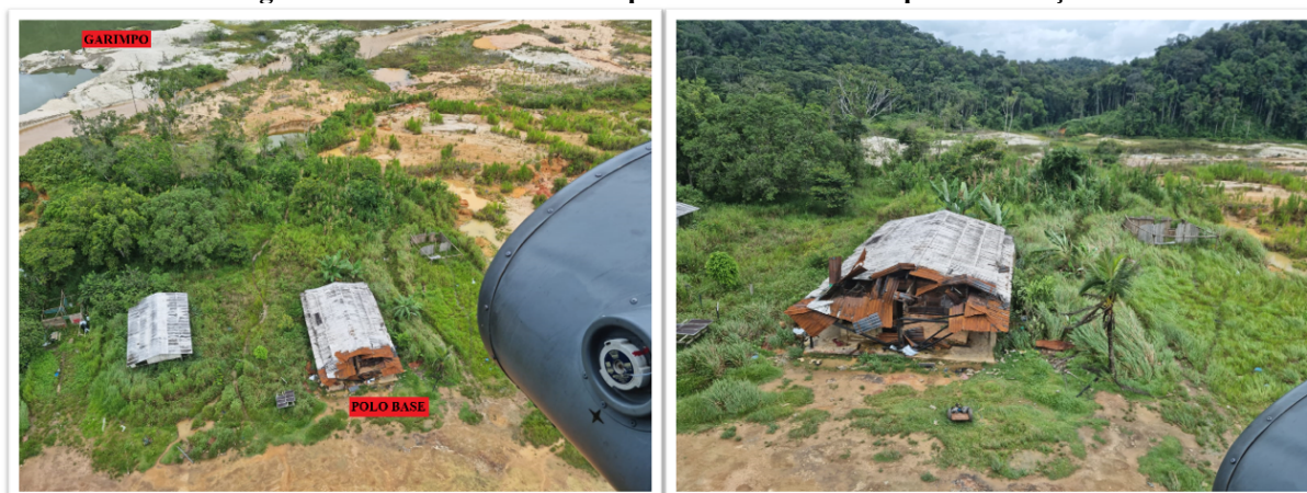
Figura 19 - Polo Base Homoxi após o incidente de ataque à edificação
