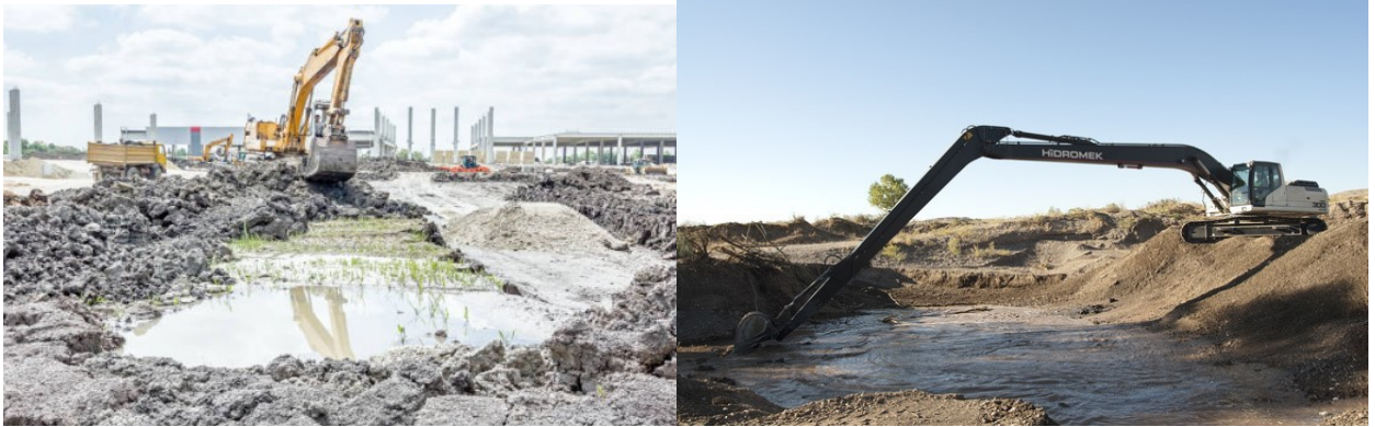
Figura 1 – Escavadeira hidráulica de longo alcance
