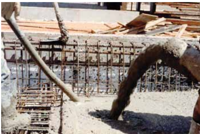
Figura 13 – Concretagem de uma laje e suas respectivas vigas
