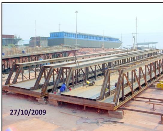
**Figura 13** – Fabricação das pontes de acesso móveis do terminal hidroviário do município de Novo Airão, em um estaleiro de Manaus
