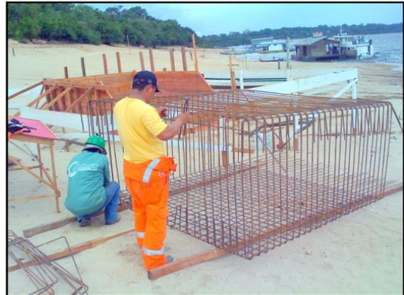
**Figura 21** – Execução das poitas do porto de Novo Airão, aproveitando o baixo nível d'água do rio Negro, na vazante
