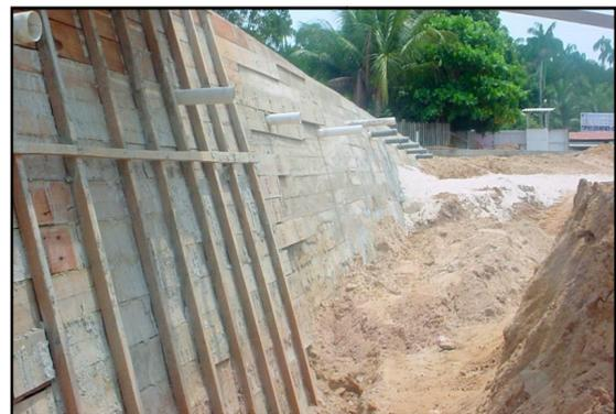
**Figuras 52, 53 e 54** – Muro de arrimo para contenção do aterro do retroporto do terminal hidroviário de Novo Airão
