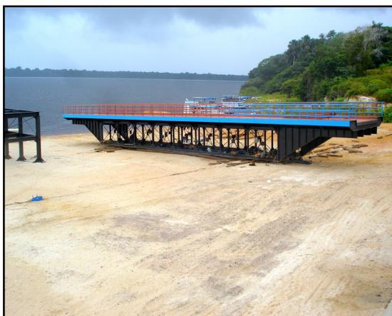
**Figura 14** – Obra de implantação do terminal hidroviário do município de Novo Airão, em 21/02/2010: montagem do primeiro vão da ponte de acesso, do tipo fixo, com 37 m de vão
