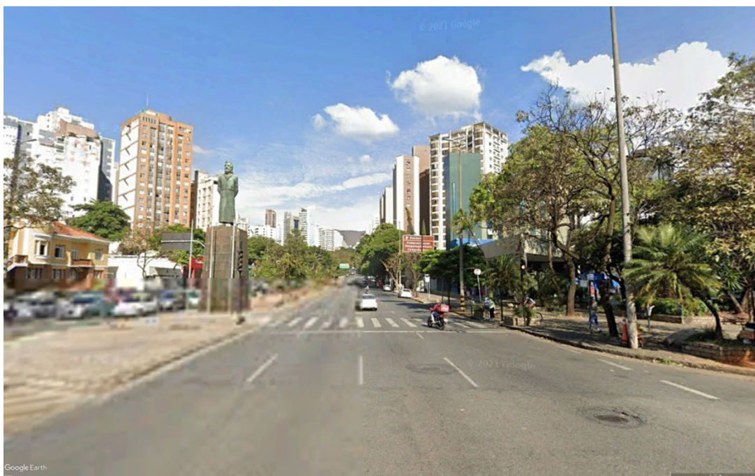
Figura 12 – Rodovia Típica em Contexto Centro-Urbano
