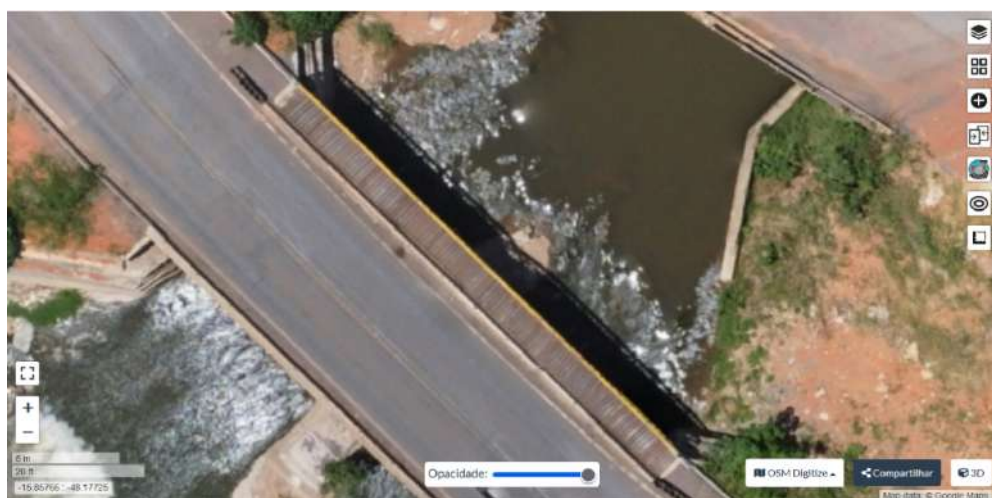
Figura 5 - Imagem de Drone com GSD de 2,44 cm mostrando os elementos da ponte provisória
